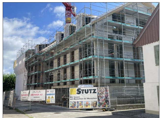
Die Dächer der «Krone» sind montiert.
